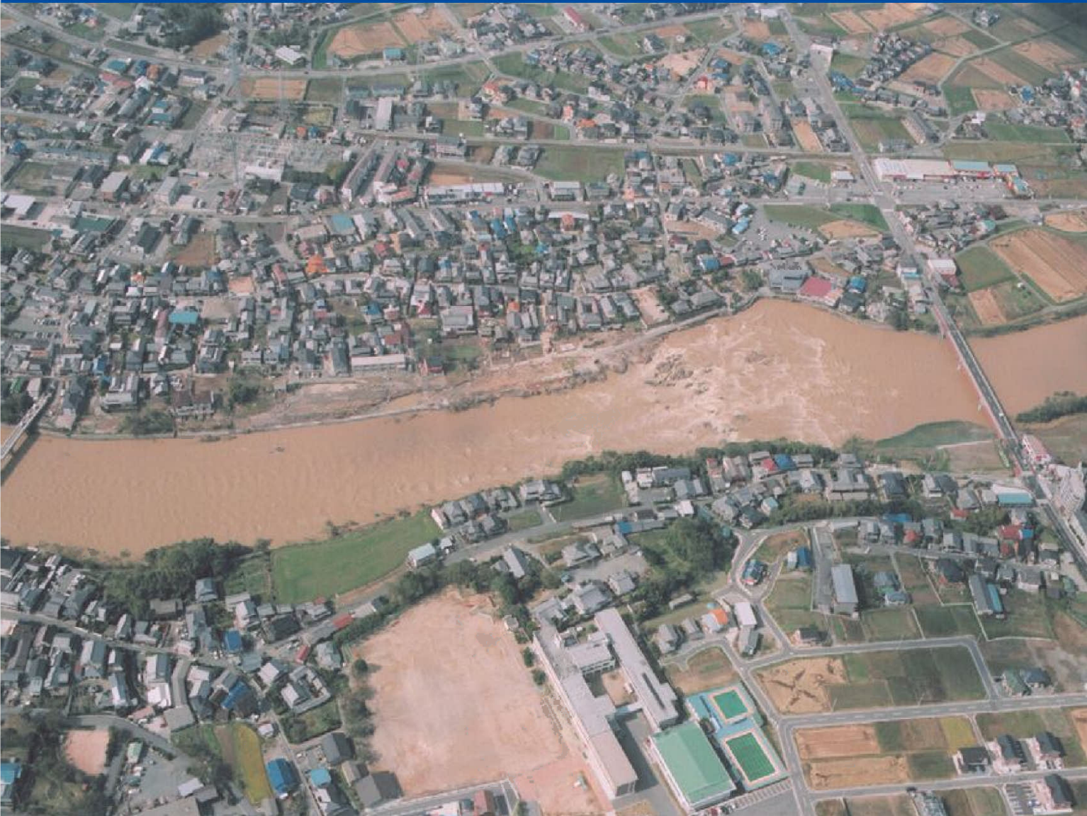
平成16年台風23号 加古川 関電灘 付近(浸水後の状況)
