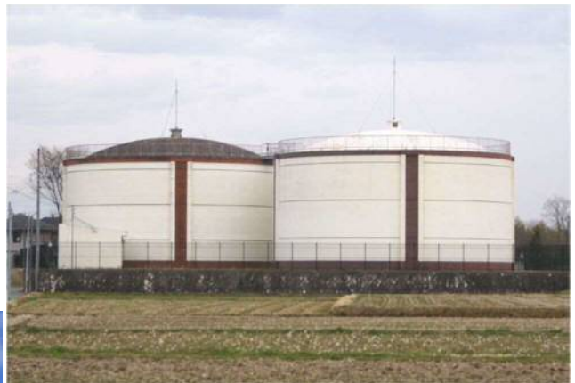
1981（昭和56）年、1985（昭和60）年築造 高区配水池（プレストレストコンクリート構造）
