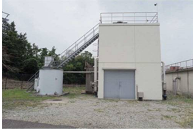
粉末活性炭混和設備
