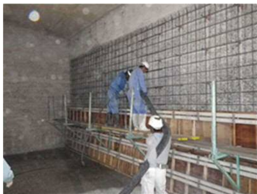
配水池耐震補強工事（例）
