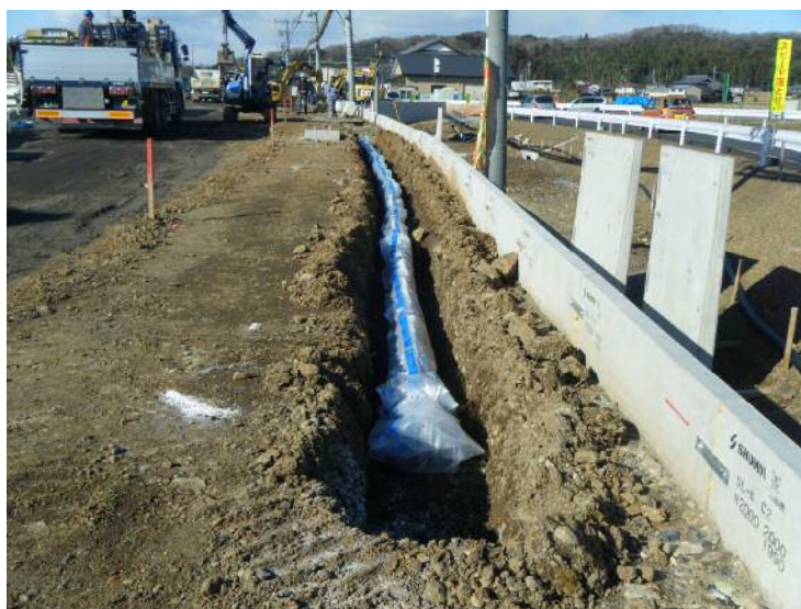
耐震管の埋設状況
