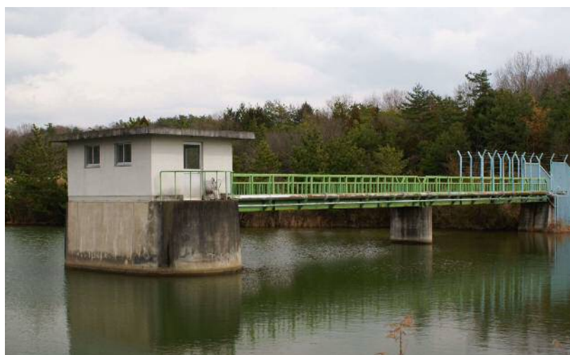
山国取水場（中新池）
