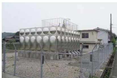
岩屋中継 ポンプ所
