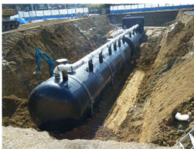
社中央公園（緊急用貯水槽 200m 3 ）
