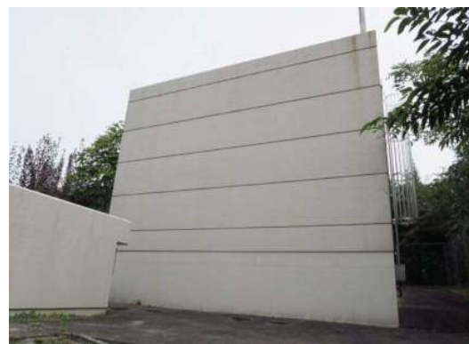
やしろ台配水池
