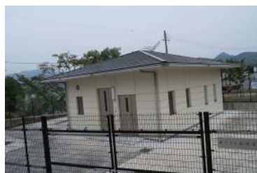
黒谷加圧 ポンプ所
