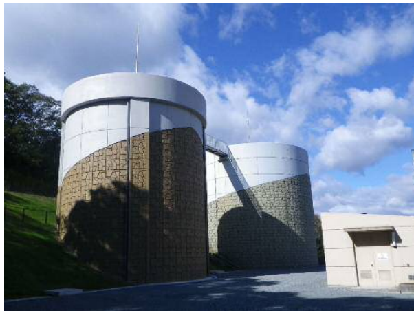
2013（平成25）年築造 南山配水池（プレストレストコンクリート構造）
