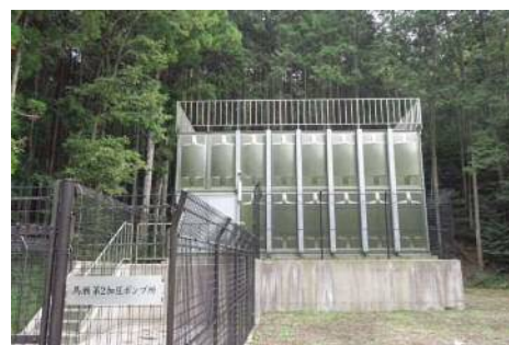
馬瀬第 2 加圧ポンプ所
