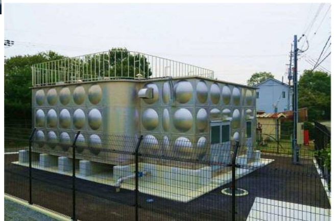
2017（平成29）年築造 嬉野東配水池（ステンレス構造）
