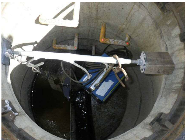
不明水調査 流量調査の様子
