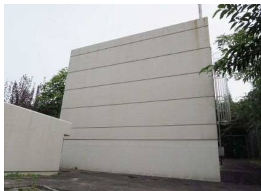
やしろ台配水池
