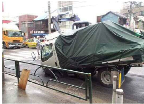
道路陥没事故の様子（国土交通省 HP より）
