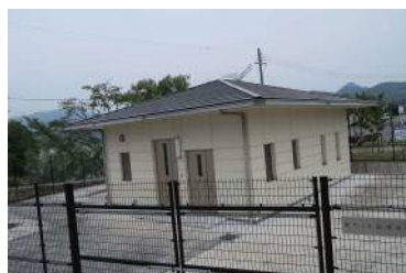
黒谷加圧 ポンプ所
