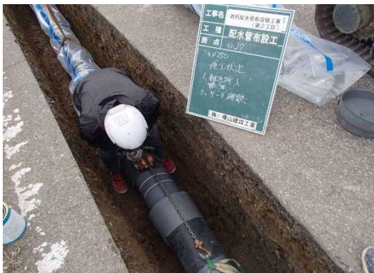
耐震管布設状況
