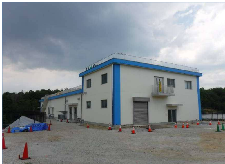
広沢浄水場（浄水設備棟）
