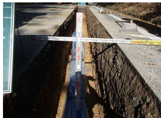
耐震管布設状況
