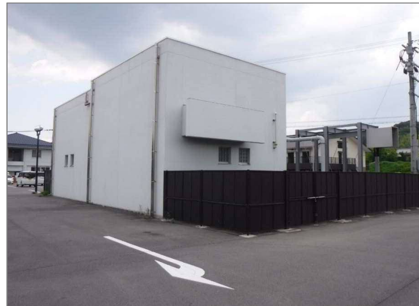
東条中継ポンプ場
