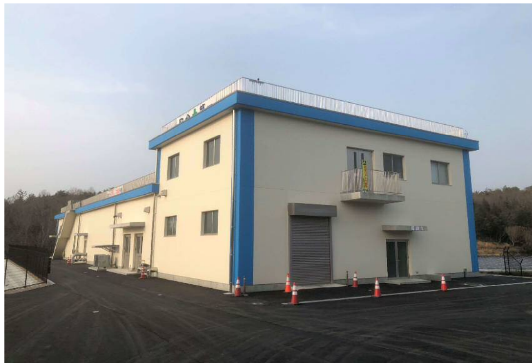
広沢浄水場・新浄水設備棟
