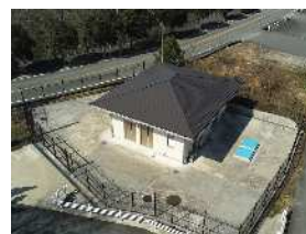
黒谷加圧ポンプ所
