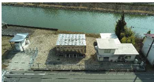
岩屋中継ポンプ所
