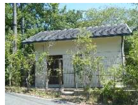
下滝野加圧ポンプ所
