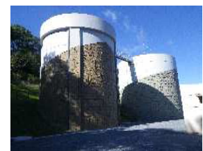
南山第1・第2配水池
