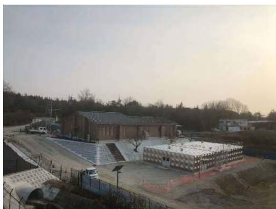
広沢浄水場管理棟・浄水池
