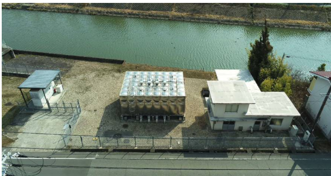
岩屋中継ポンプ所
