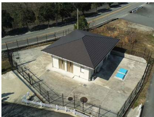
黒谷加圧ポンプ所
