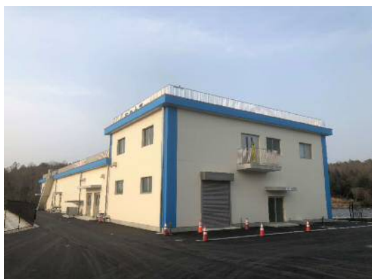
広沢浄水場浄水設備棟
