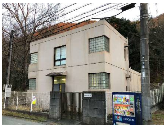
山口第1加圧ポンプ所（受水槽廃止予定）
