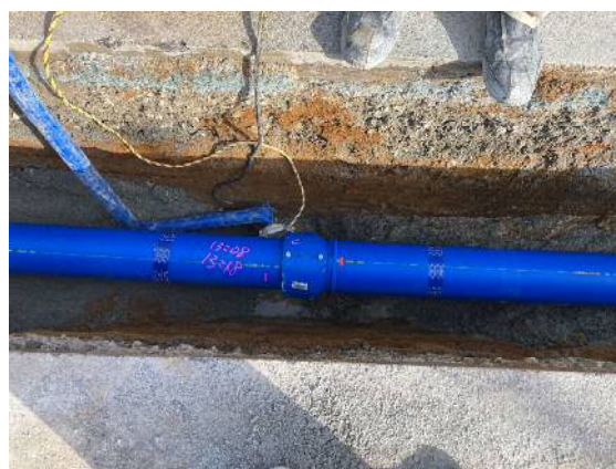
耐震性の高いダクタイル鋳鉄管（左）と配水用ポリエチレン管（右）
