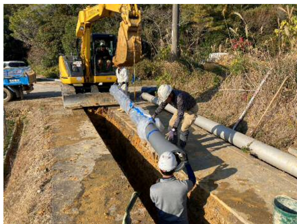
基幹管路耐震化工事の様子
