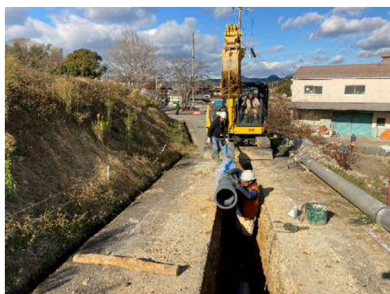
耐震性の高いダクタイル鋳鉄管（左）と配水用ポリエチレン管（右）
