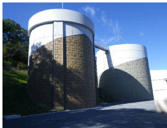
南山第1・第2配水池
