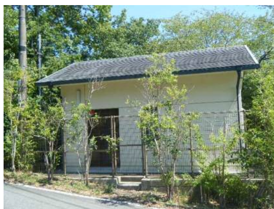
下滝野加圧ポンプ所
