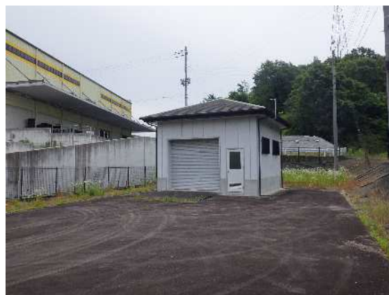
南山中継ポンプ場
