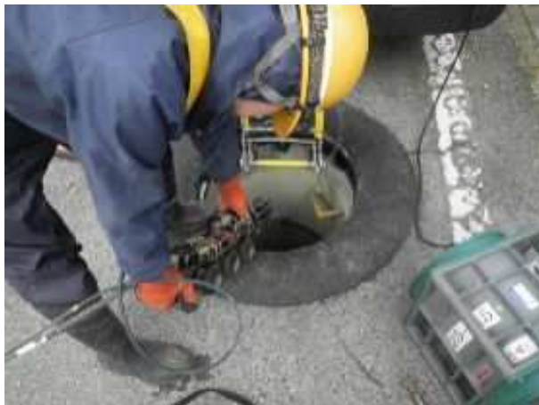
不明水調査（TVカメラ調査及びスクリーニング調査）の様子
