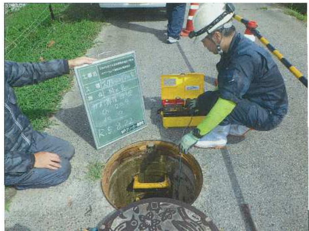
不明水調査（TVカメラ調査及びスクリーニング調査）の様子
