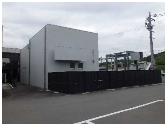
東条中継ポンプ場
