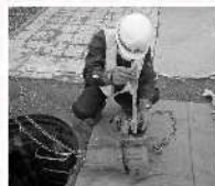
《異物除去作業》
