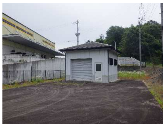
南山中継ポンプ場
