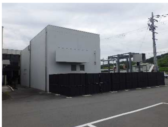
東条中継ポンプ場
