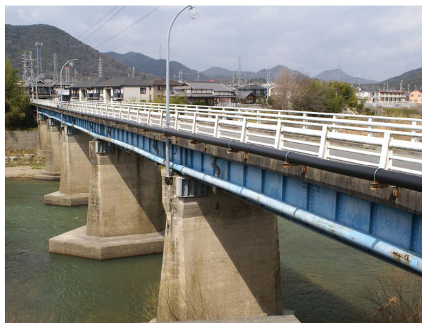
滝見橋水管橋
