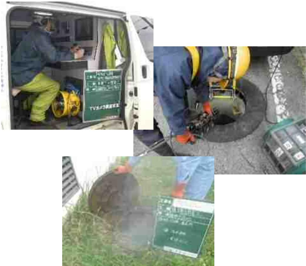
図 3-3 不明水調査 TV カメラ及び送煙調査
