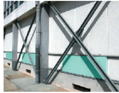
小・中学校の施設整備 3億1,618万円 (耐震補強、防犯カメラなど)
