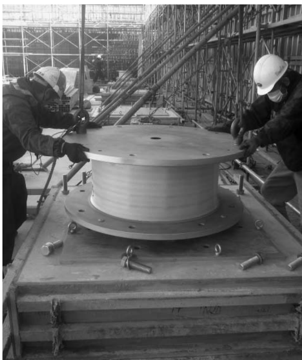
免震装置設置のようす。中央のくびれた部分がゴムできており、地震の揺れを吸収します。
