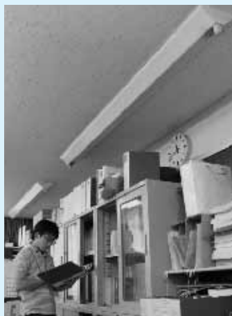
蛍光灯の間引き点灯
