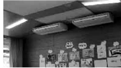
小学校・幼稚園空調の設置 3億6,573万円
