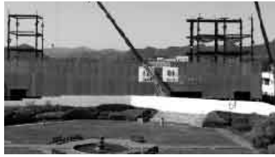
庁舎統合整備(H24年度施工分) 5億614万円
