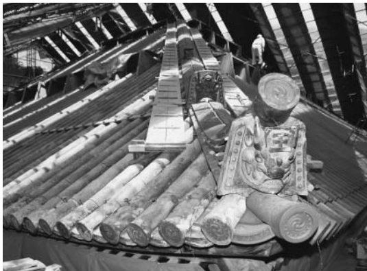
屋根の一部には、昔からの瓦が再利用されています。
