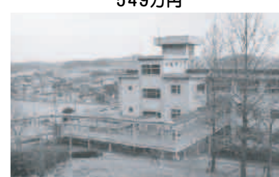
中学校施設整備事業 （東条中学校バリアフリー化工事他） 1億0,215万円
