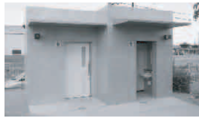
都市公園トイレ改修 （上中第1公園・大蔵公園） 1,374万円
