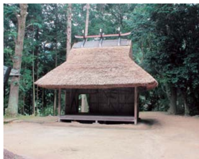
工事が完了した舞堂
