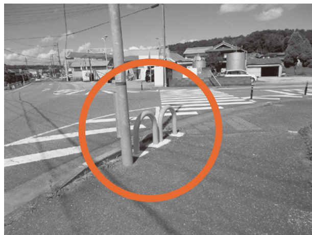
【安全対策が施された例】 ガードパイプの設置(加東市下久米599付近)
