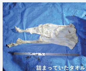
詰まっていたタオル
