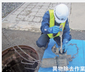
異物除去作業
