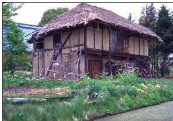
屋根材がワラの例
