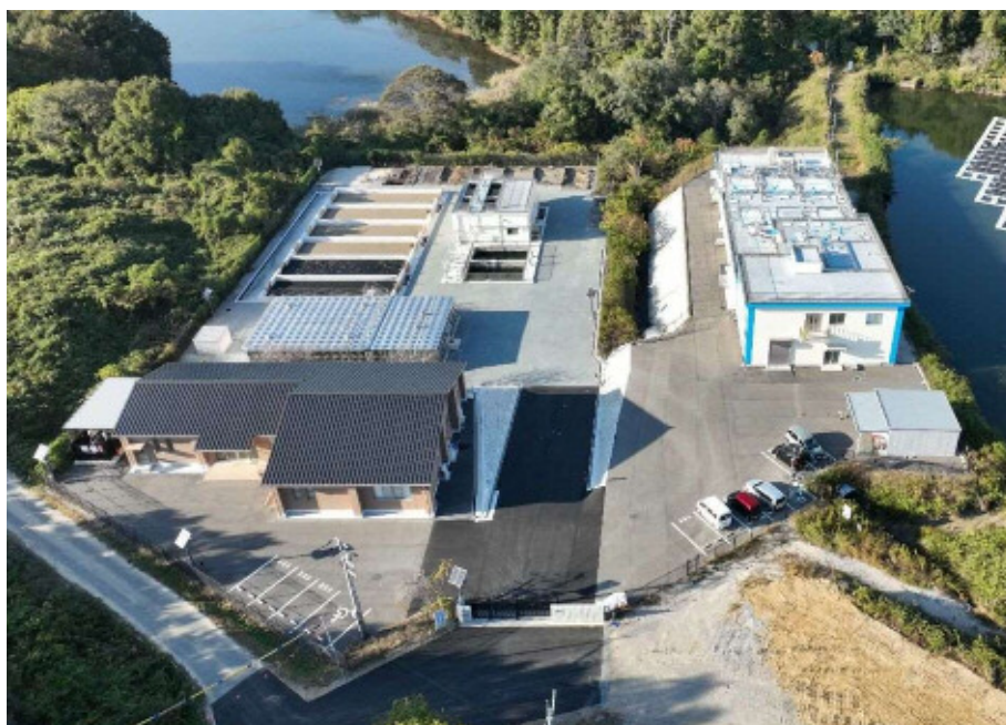
統合浄水場（広沢浄水場）完成写真
