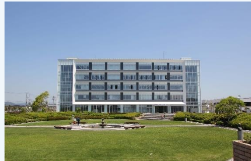
新庁舎の外観写真
