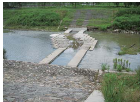
千鳥川の沈下橋と石積護岸
