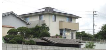
住宅の太陽光発電（パネル）の設置
