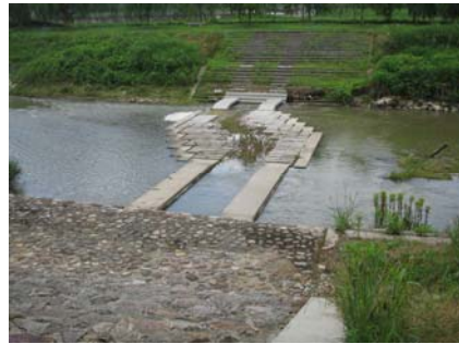
千鳥川の沈下橋と石積護岸
