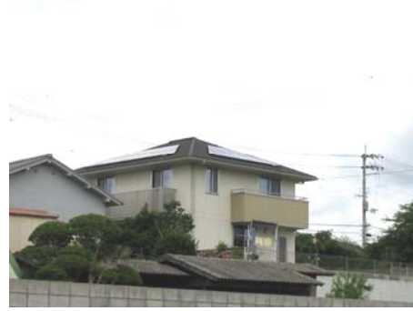
住宅の太陽光発電（パネル）の設置
