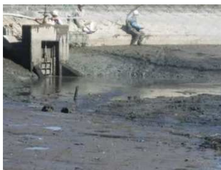
泥土除去後の状況(かいぼり実施後)
