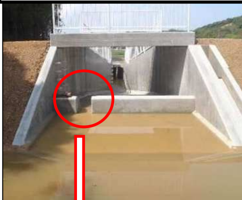
【南あわじ市 洪水吐越流堰の切欠き】
