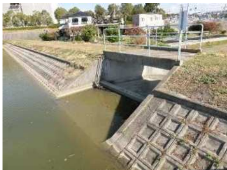
洪水吐(上流側)
