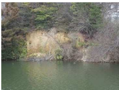
ため池周囲 土砂崩壊
