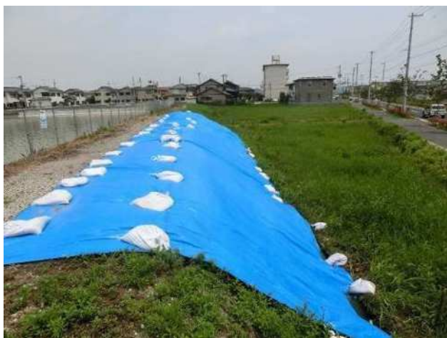
堤体下流法面にブルーシート設置
