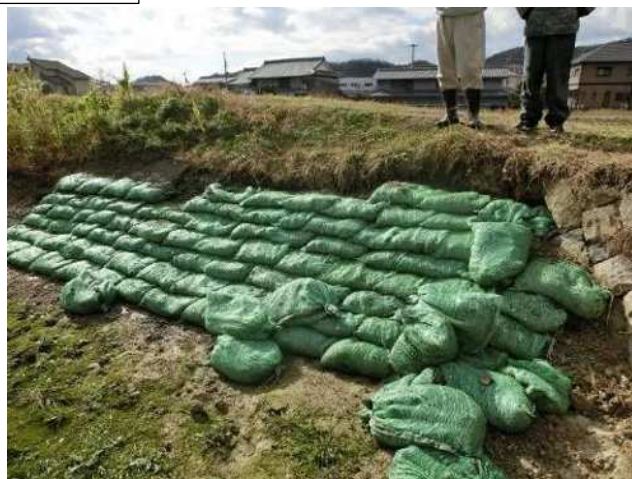
堤体上流法面に土のう設置
