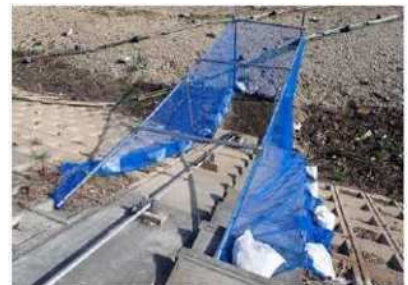
取水施設周りに防風ネットを設置
