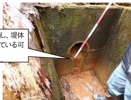
底樋出口(堤体下流)
