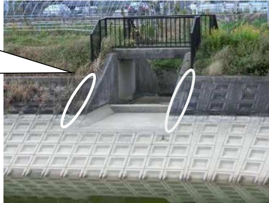
洪水吐(貯水池側より)
