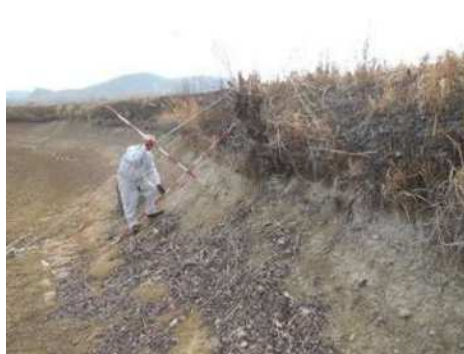
堤体の浸食状況等の点検
