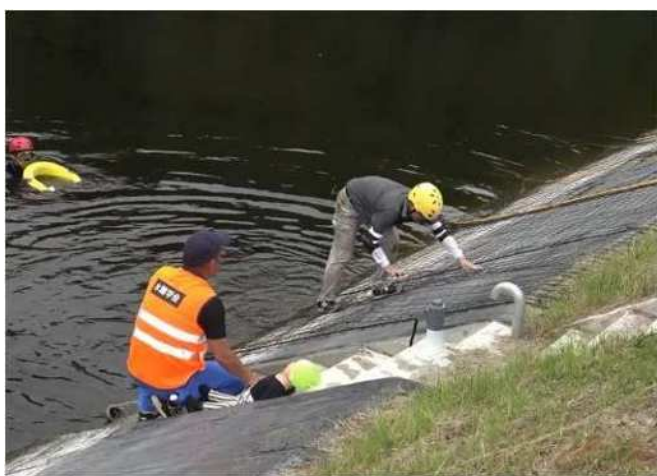
法面にネットの設置
