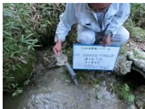
後法 漏水量測定(遠景)
