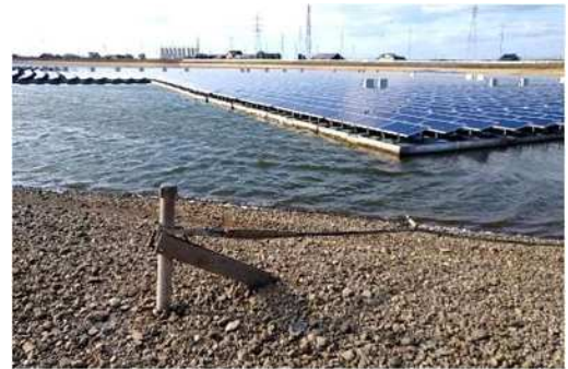
打ち込みアンカーによる係留
