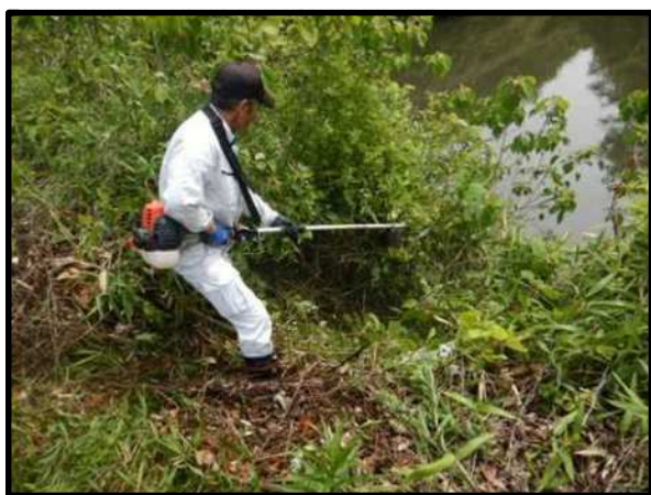
ため池前法での草刈作業の様子
