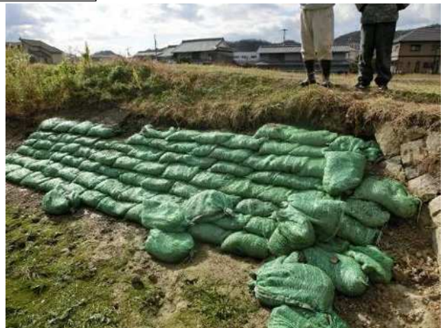
堤体上流法面に土のう設置
