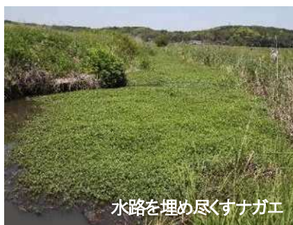
水路を埋め尽くすナガエ 水路やポンプ吸水槽などを閉塞し、 取水・排水を阻害する
