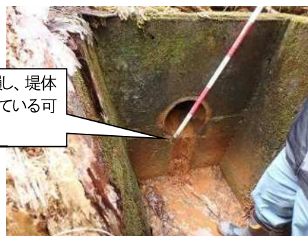
底樋出口(堤体下流)
