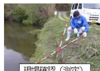
現場確認（測定）
