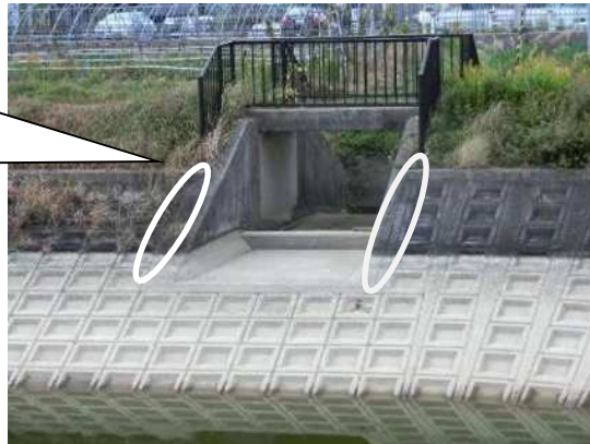
洪水吐(貯水池側より)
