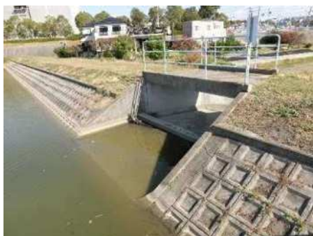
洪水吐(上流側)
