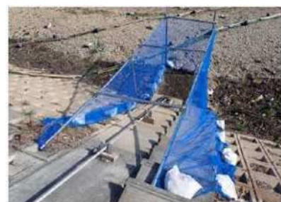
取水施設周りに防風ネットを設置
