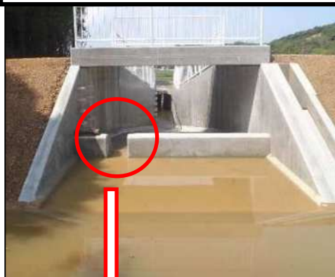
【南あわじ市 洪水吐越流堰の切欠き】
