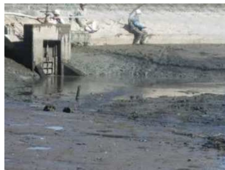
泥土除去後の状況(かいぼり実施後)
