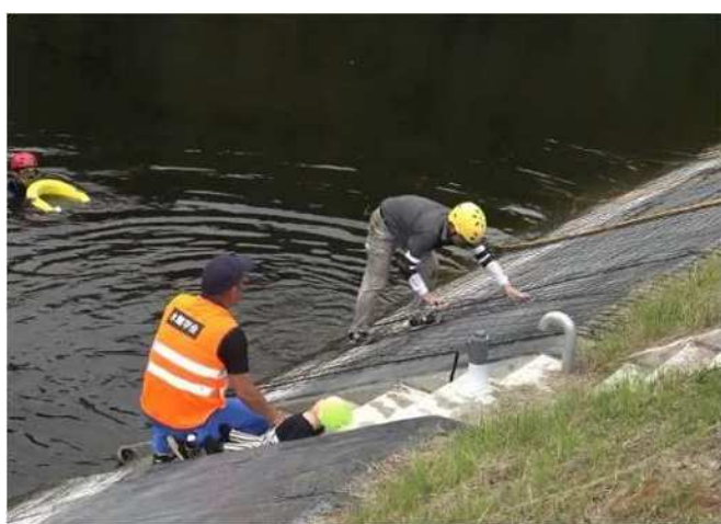
法面にネットの設置
