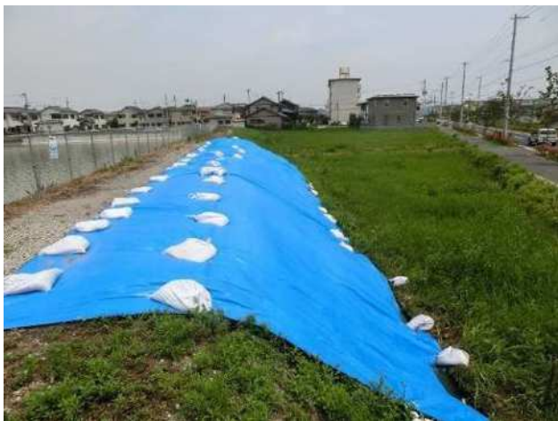
堤体下流法面にブルーシート設置
