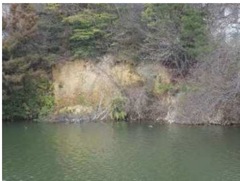
ため池周囲 土砂崩壊
