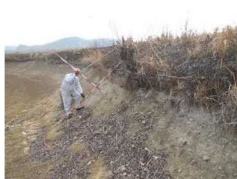
堤体の浸食状況等の点検
