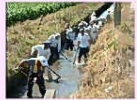
水路の泥上げ
