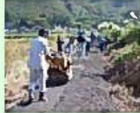
未舗装農道の舗装
