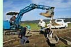
コンクリート水路の更新
