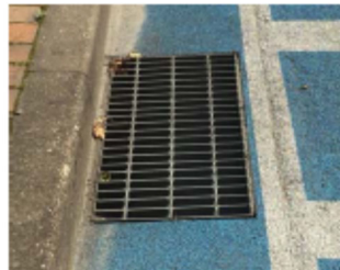
グレーチング蓋の格子の形状等を工夫した事例
