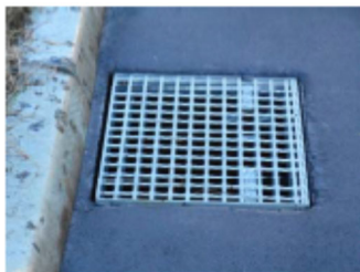
グレーチング蓋の格子の形状等を工夫した事例
