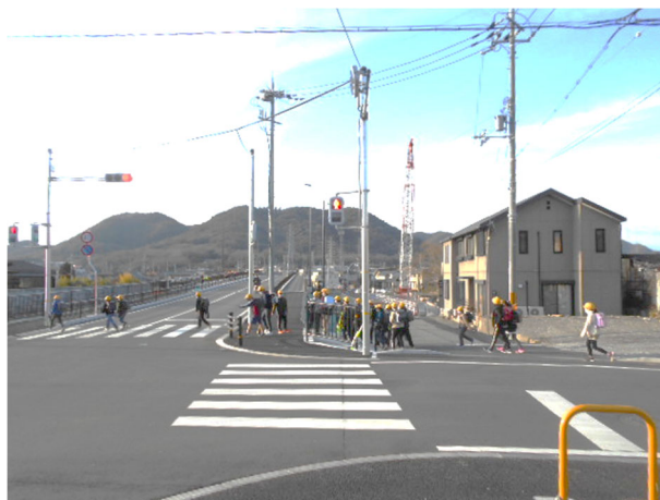
対策後の通学路の状況
