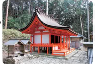
④山中で神々しさを放つ本殿。拝観は外からのみ
