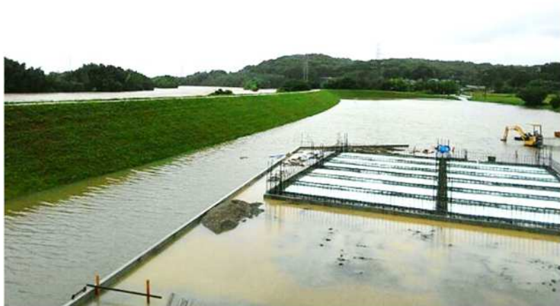
平成30年7月豪雨 (安取雨水ポンプ場整備工事 施工中)
