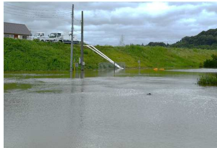
平成22年度に購入した排水ポンプパッケージ車 による排水状況（排水能力：10m 3 /分）
