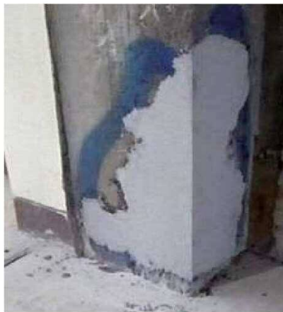
はずりとした部分に無収縮モルタルを塗付
