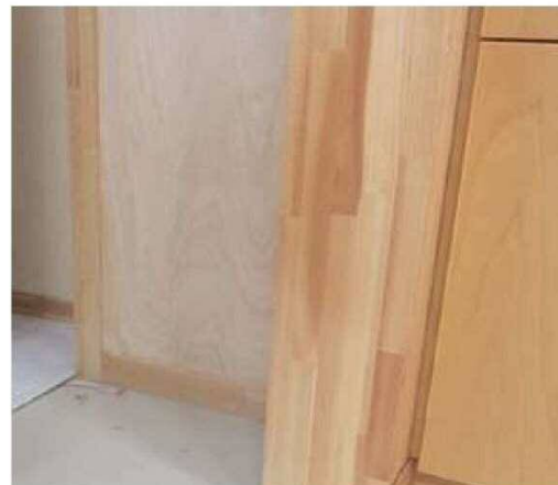
補修完了後に木仕上げを実施
