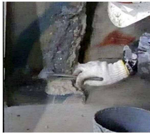
モルタルの付着を良くするための下地材を塗布
