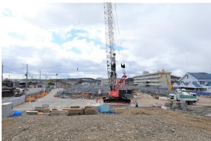
↑南東から見た全体写真
