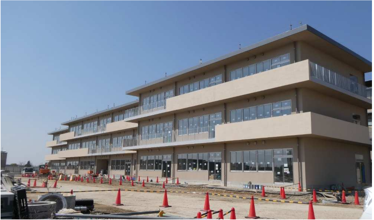
増築校舎棟 外観（令和6年3月15日撮影）
