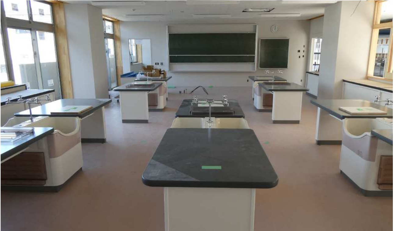
増築校舎棟 3階 理科室内装工事状況（令和6年3月15日撮影）
