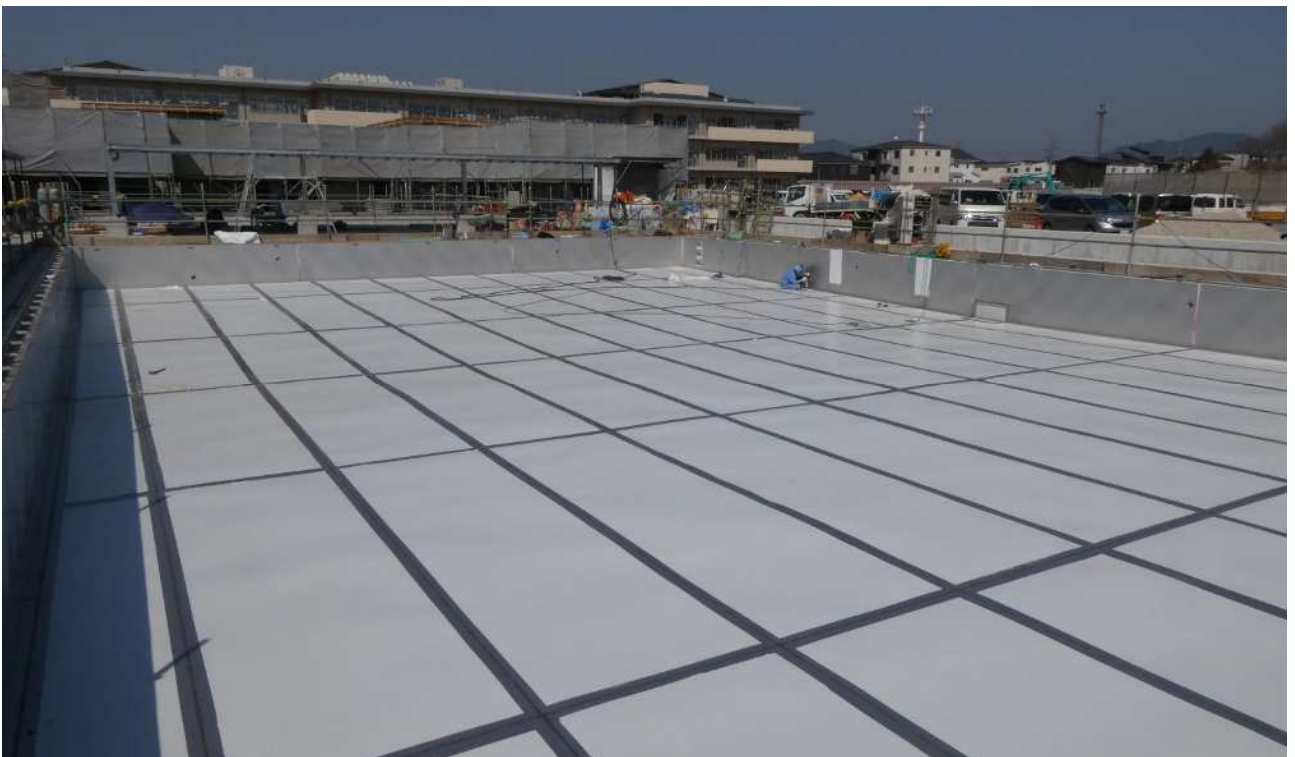
プール棟 プール水槽（大プール）設置状況（令和6年3月15日撮影）
