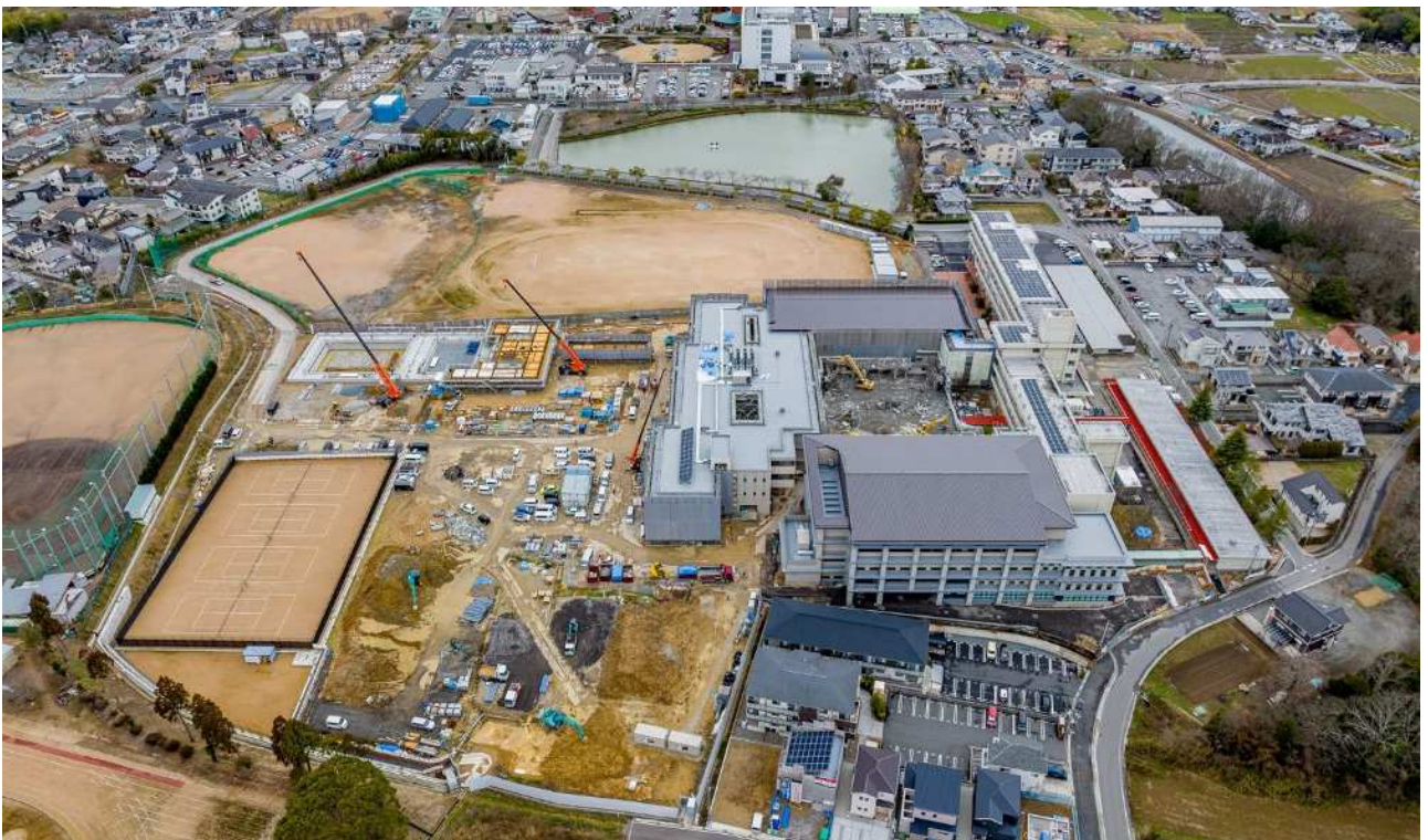
全景 東側上空から撮影（令和6年2月27日撮影）
