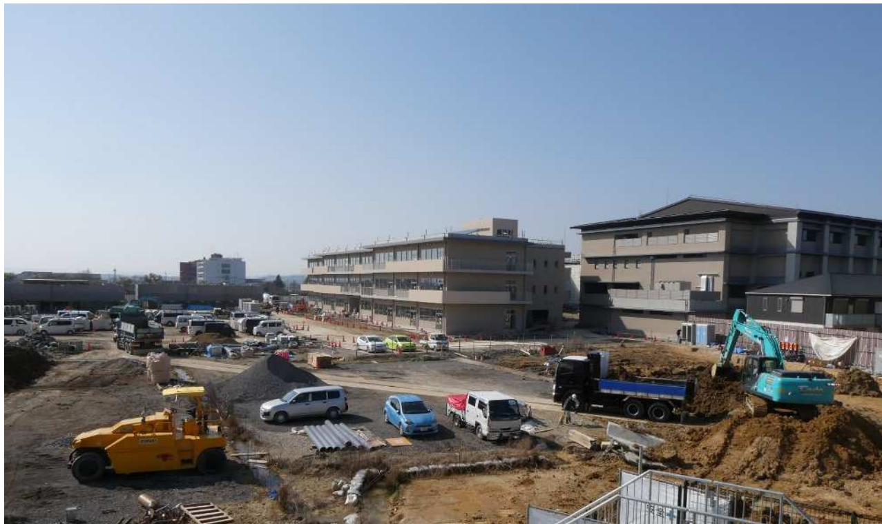
現場南東側からの工事状況（令和6年3月15日撮影）
