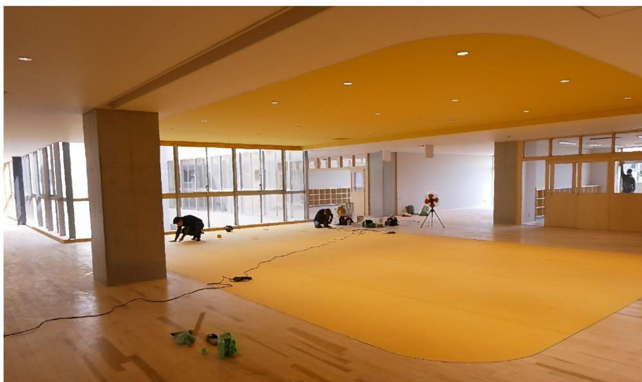
増築校舎棟2階 多目的スペース（令和6年4月12日撮影）
