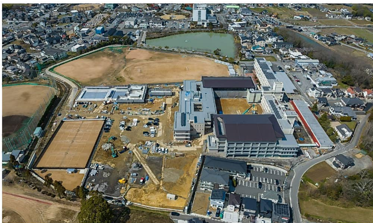
全景 東側上空から撮影（令和6年3月31日撮影）
