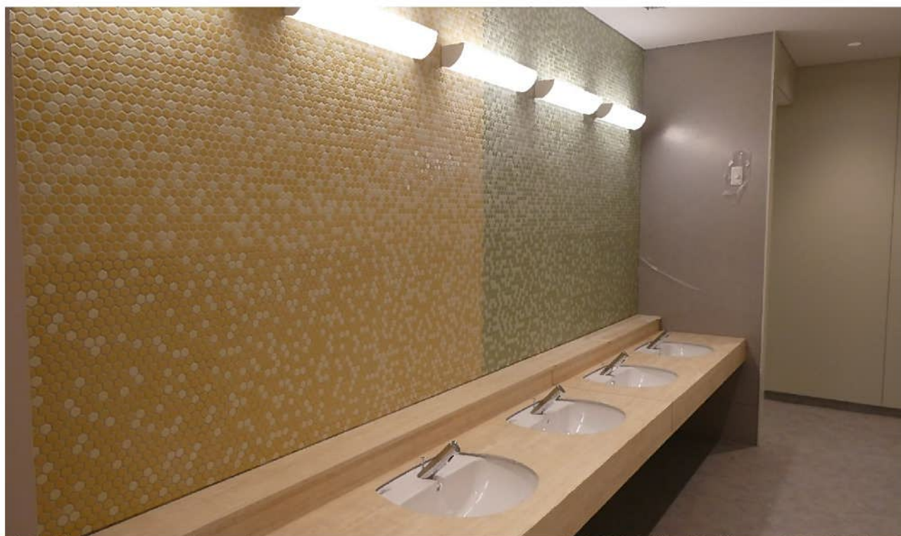
増築校舎棟 トイレ前手洗い（令和6年4月12日撮影）
