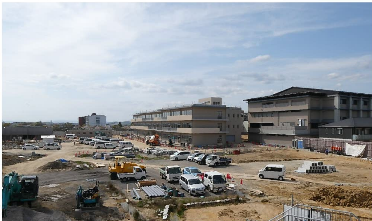
現場南東側からの工事状況（令和6年4月12日撮影）
