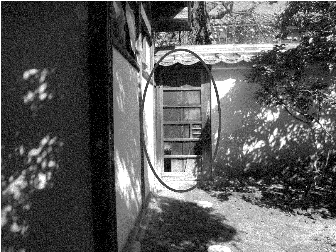
三草藩武家屋敷旧尾崎家（通用口扉）【市施設・市指定文化財】
