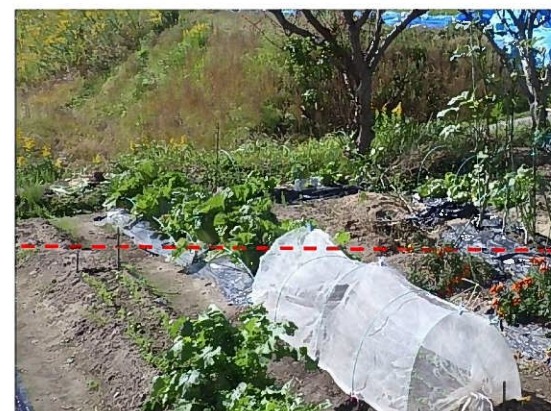
⑭. 右側側部 耕作地亀裂
