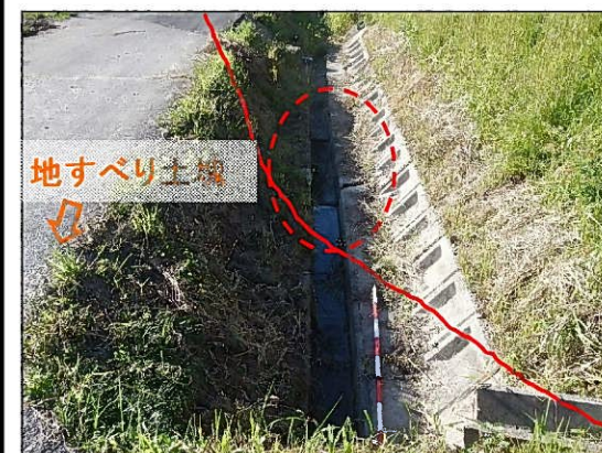
⑮. 市道新定2号線 No.5付近側溝
