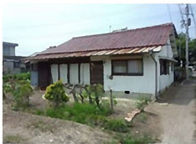
木造瓦葺 2 階建物件
