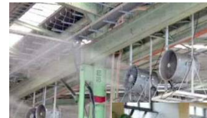
(整備の一例) 換気扇の設置
