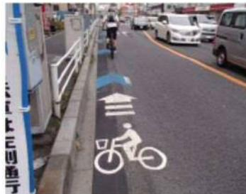
ピクトグラムを設置した事例（車道混在型）
