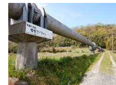
3号幹線水路 曽根サイホン
