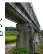
1号幹線水路 1号水路橋
