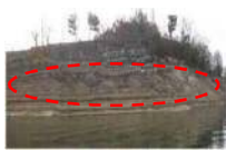
鴨川ダム貯水池内法面の浸食
