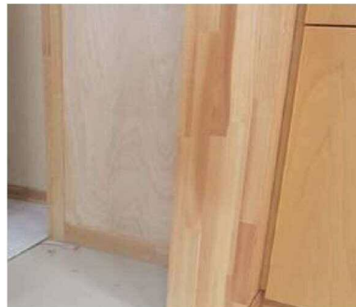
補修完了後に木仕上げを実施
