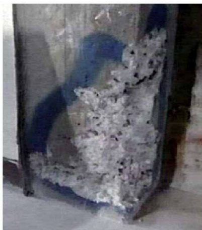
欠損部分のまわりをはずりとした状態
