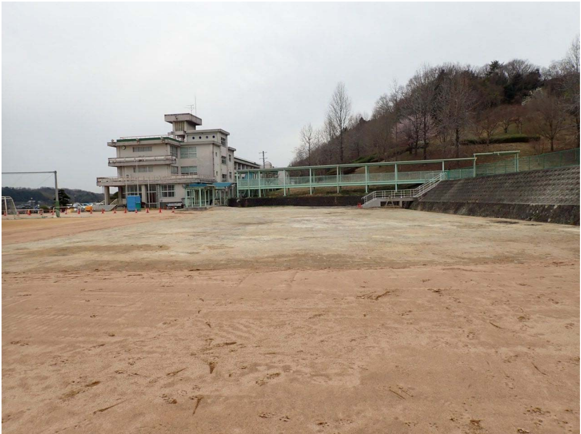
体育館棟の解体状況 近景
