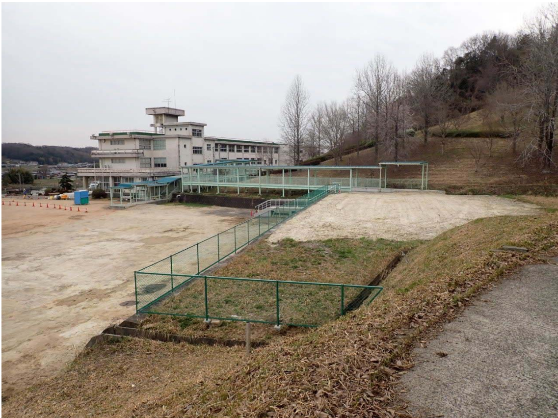
体育館棟と柔剣道場棟の解体状況 近景
