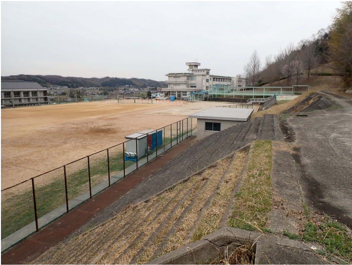
体育館棟と柔剣道場棟の解体状況 遠景
