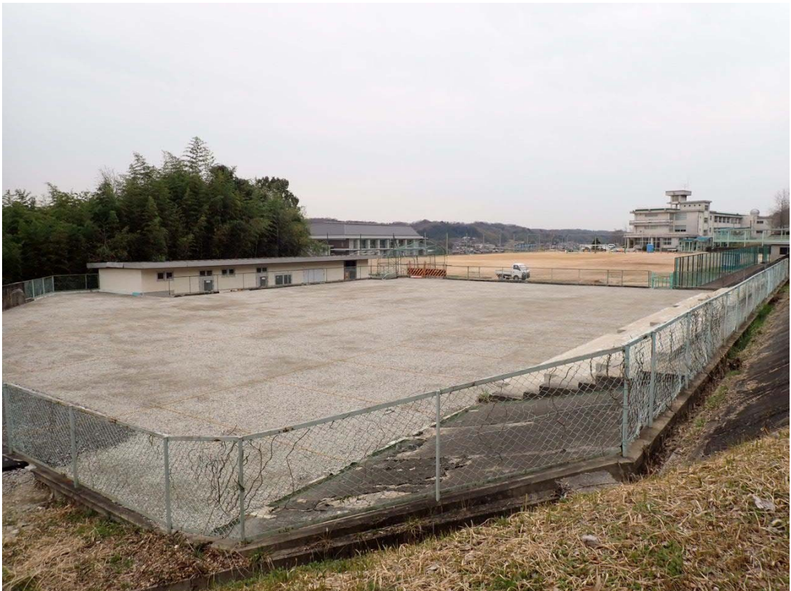
プールの解体状況 近景
