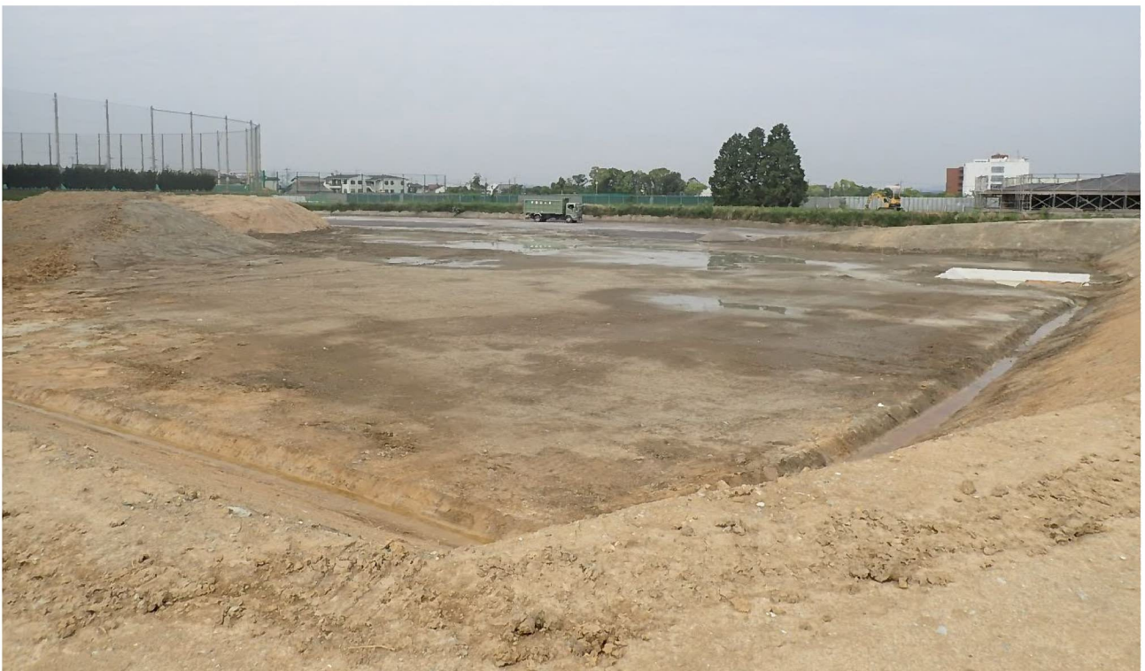
カセ池工事状況 その2
