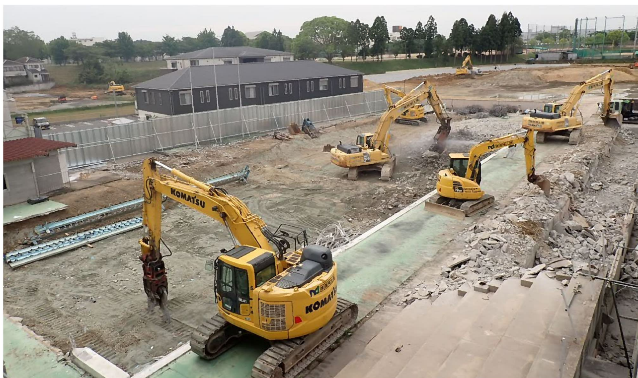
プール解体状況 その2
