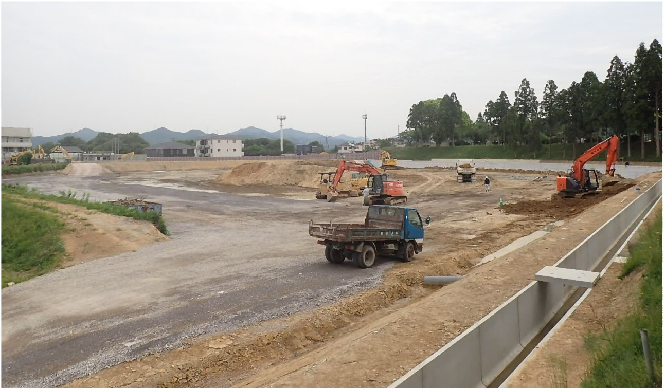
カセ池工事状況 その1
