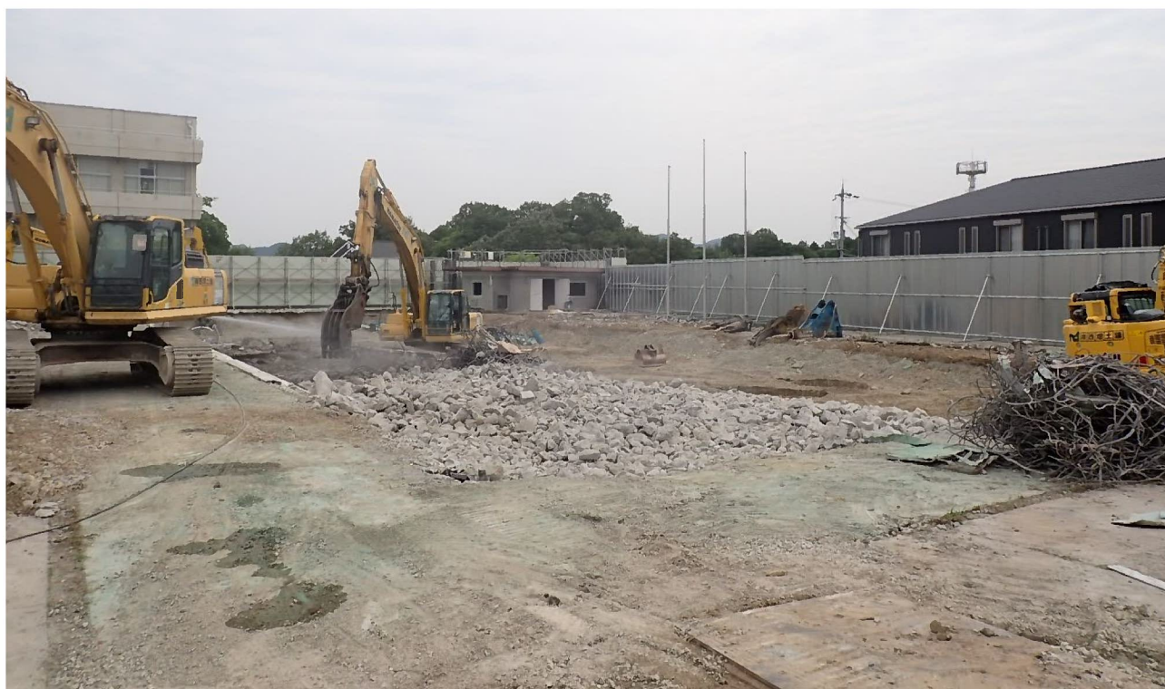
プール解体状況 その1
