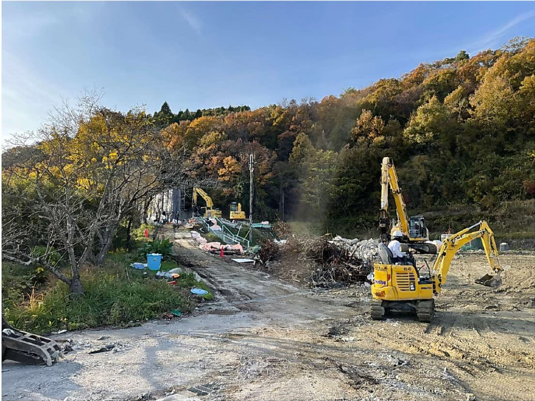
技術棟 解体中
