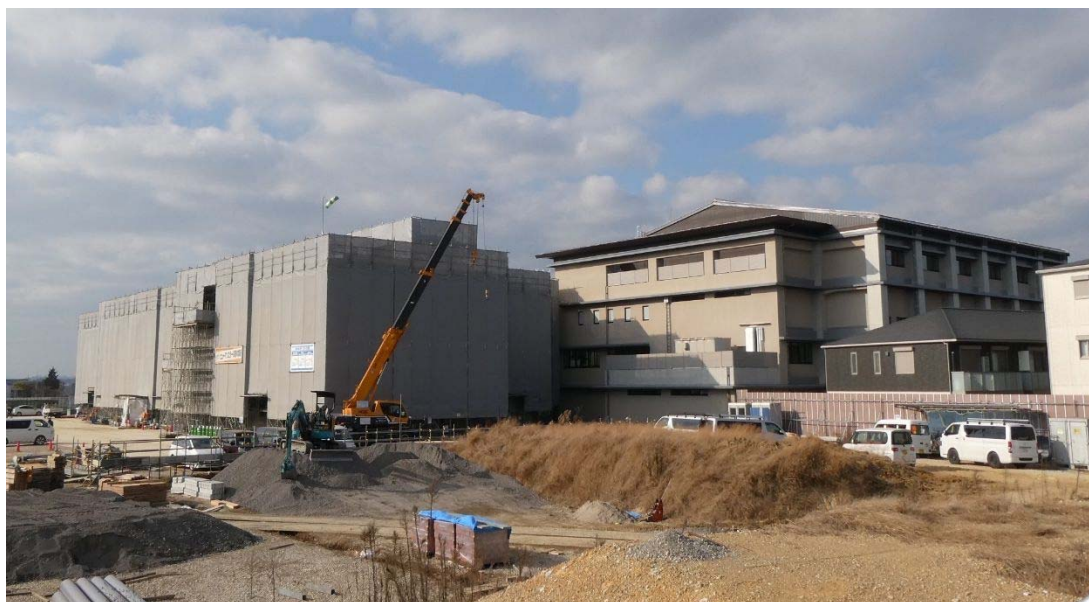
現場南東側からの工事状況（令和5年12月26日撮影）
