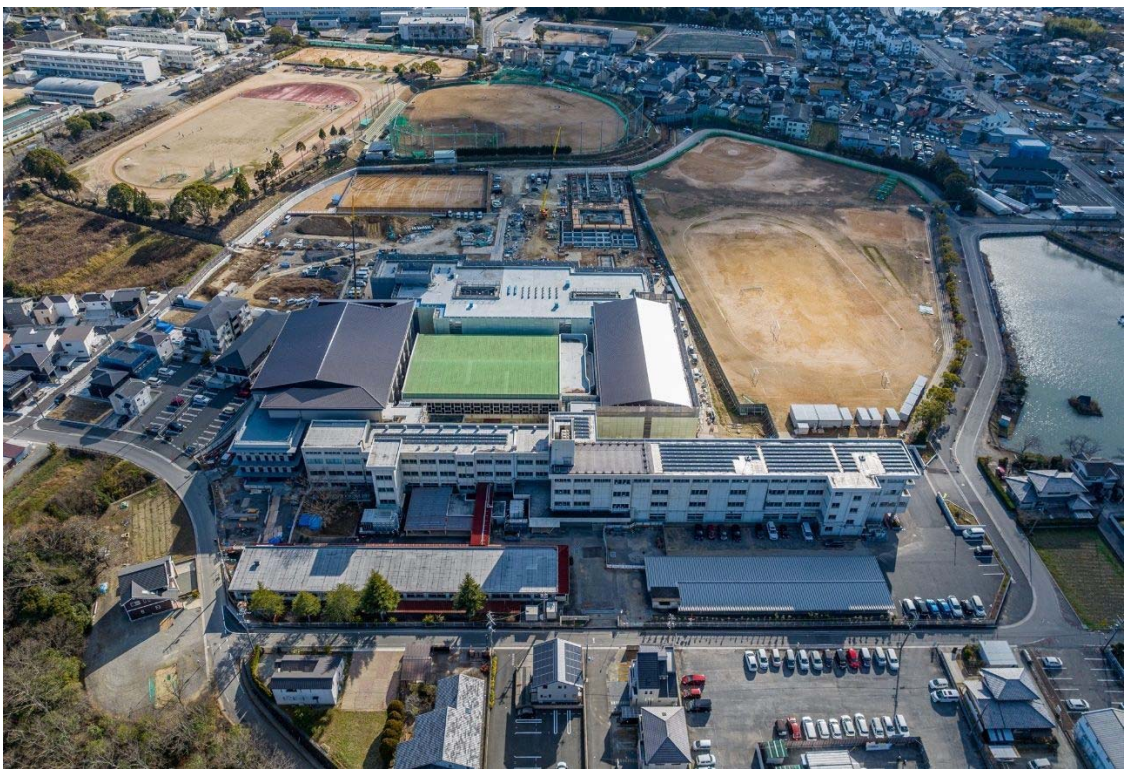
全景 北側上空から撮影（令和5年12月26日撮影）
