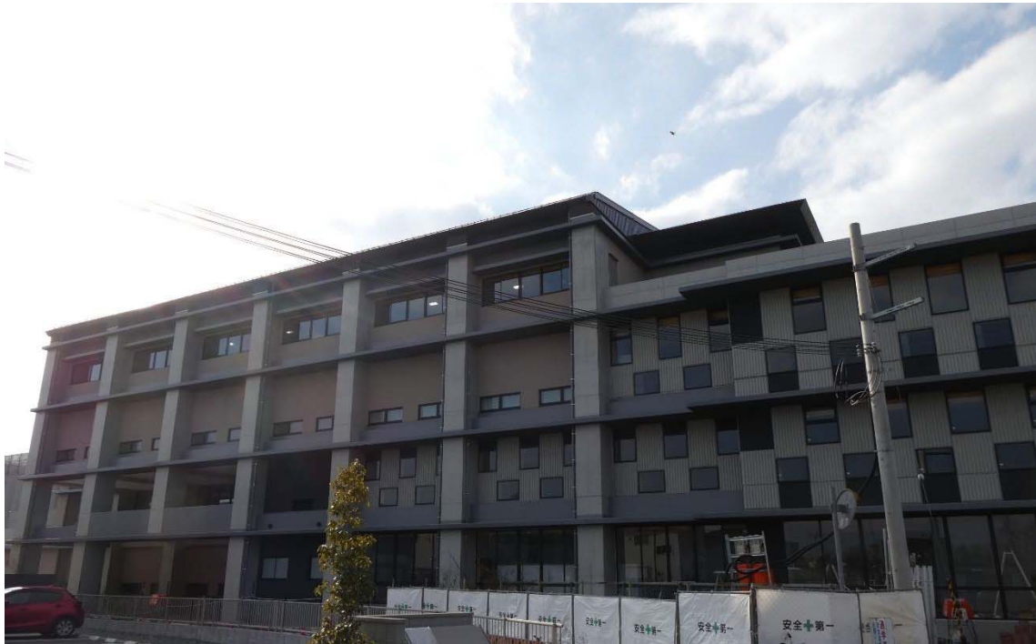
屋内運動場棟 北東側外観（令和5年12月26日撮影）
