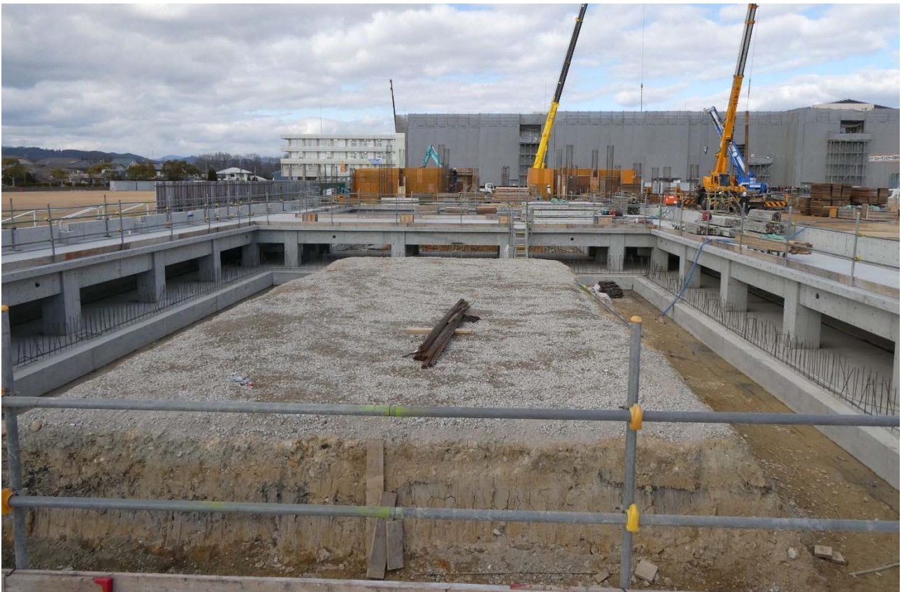
大プール 工事状況（令和6年1月29日撮影）
