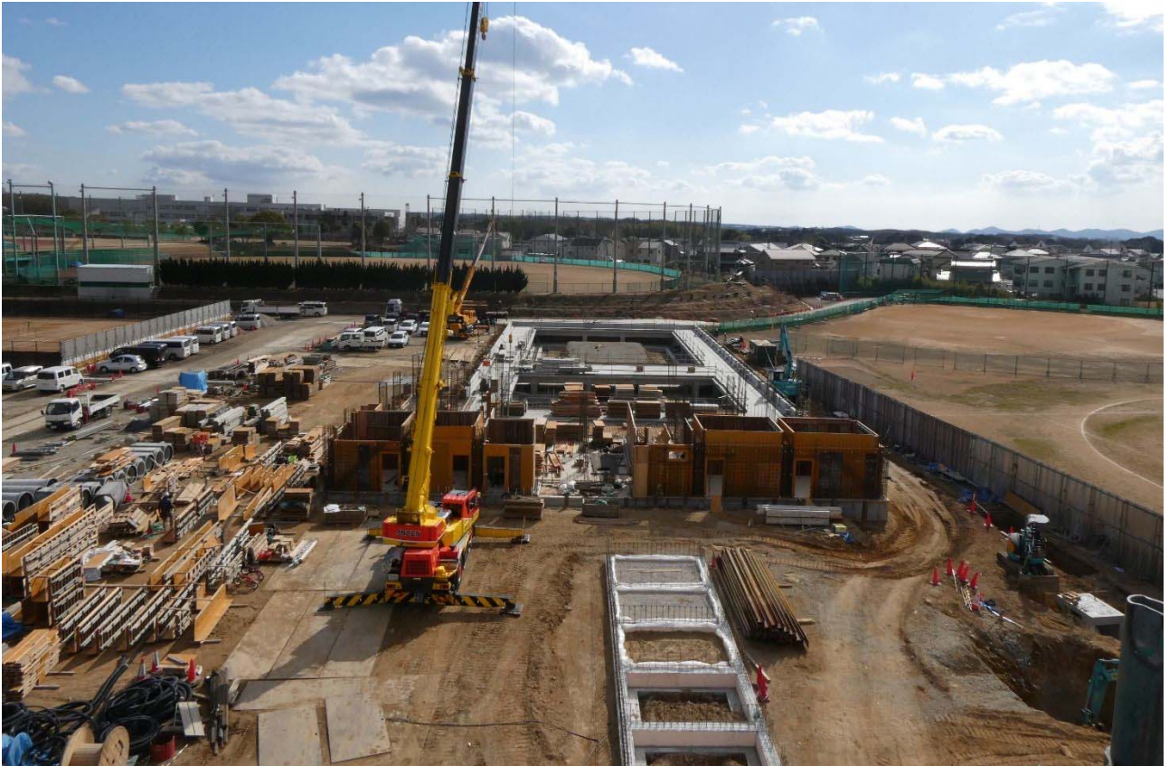
プール棟・部室棟 工事状況（令和6年1月29日撮影）
