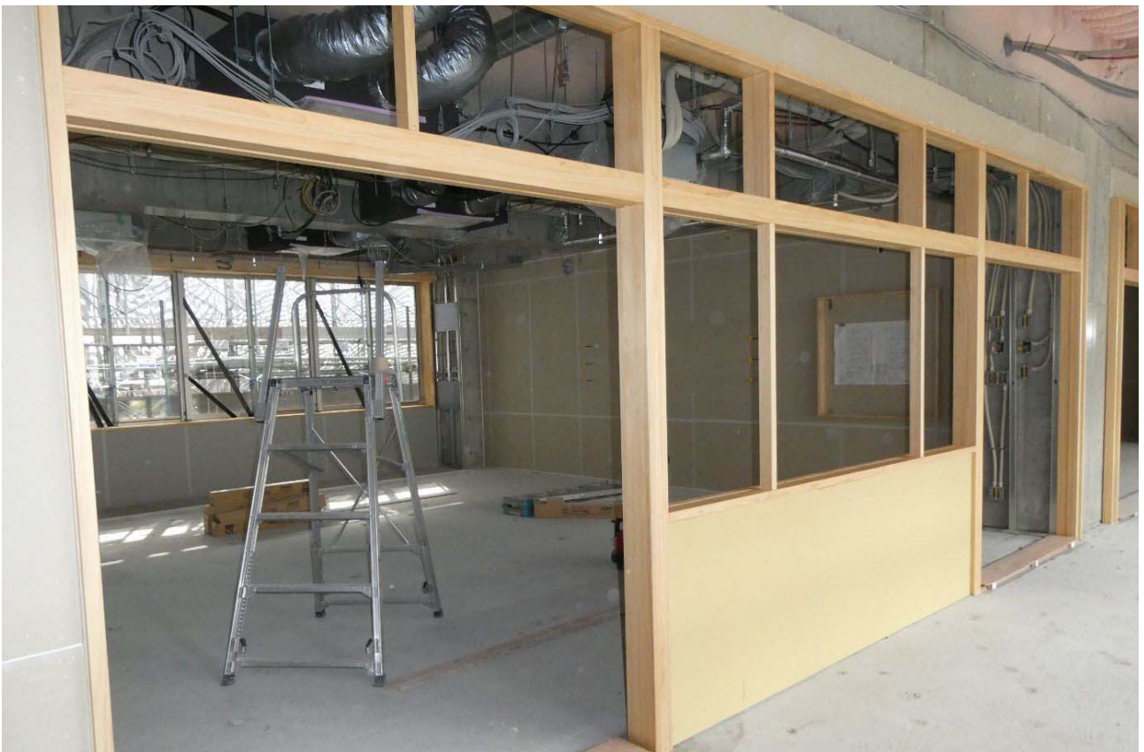
増築校舎棟 普通教室内装工事状況（令和6年1月29日撮影）
