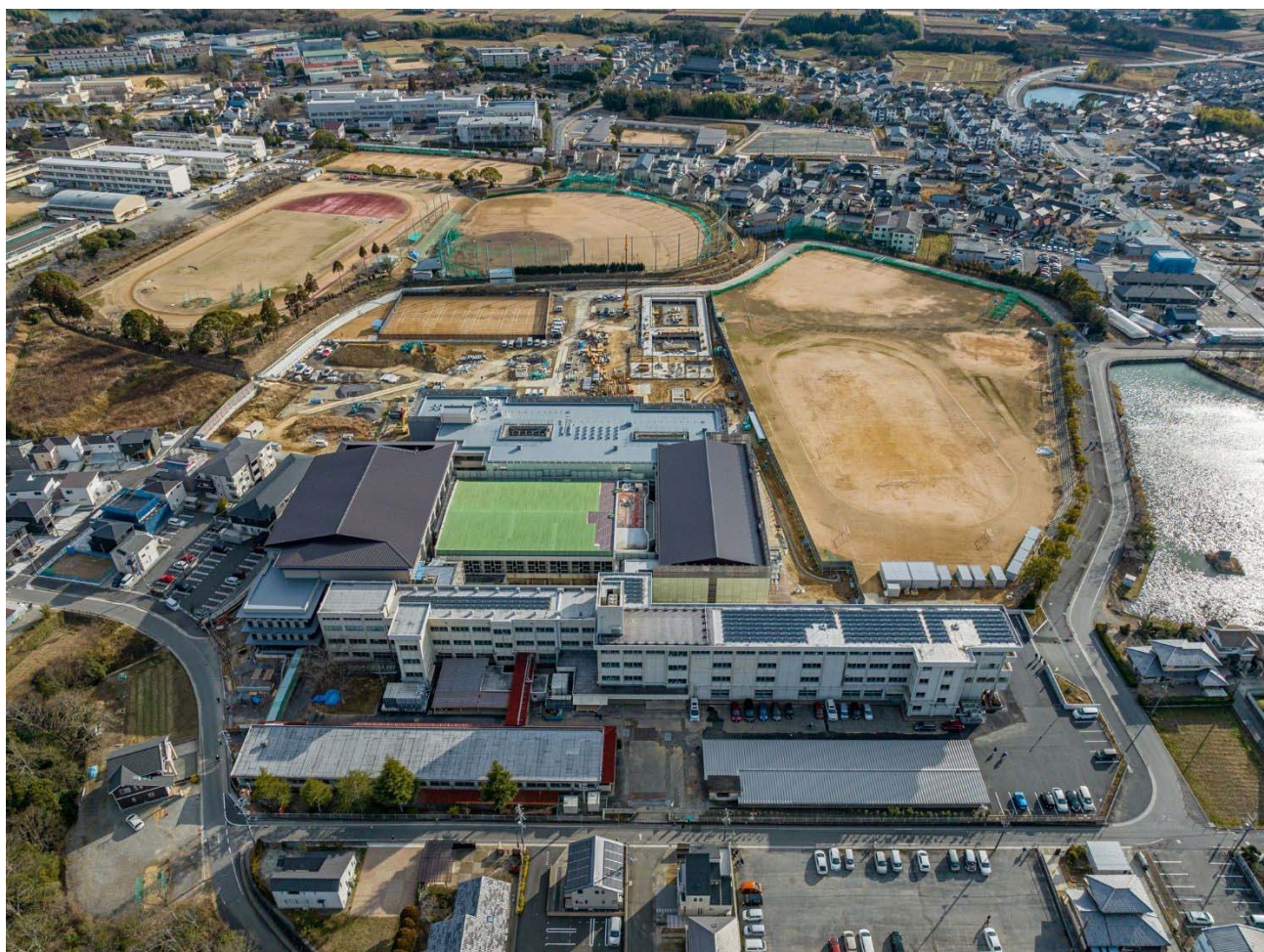
全景 北側上空から撮影（令和6年1月30日撮影）
