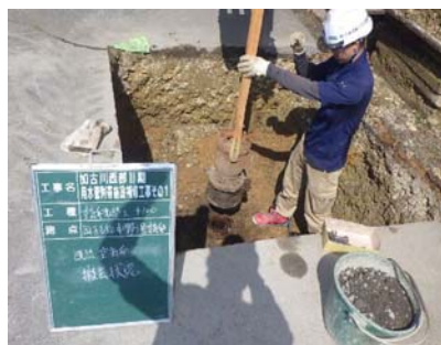
既設空気弁撤去
