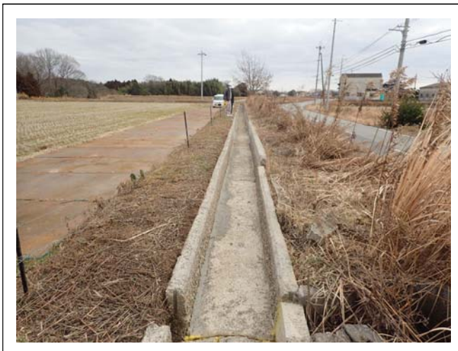
水路改修状況（新設）
