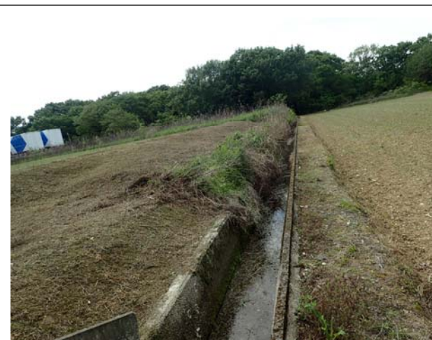
水路補修状況（表面被覆工法）
