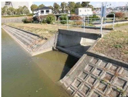
洪水吐(上流側)
