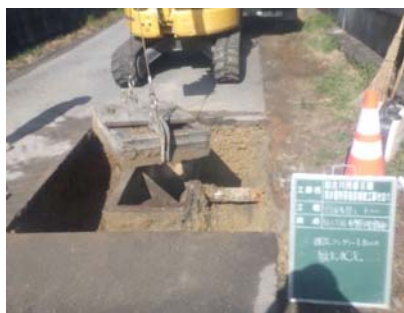
空気弁BOX撤去
