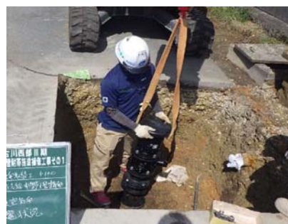
空気弁設置
