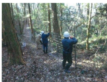
＜金網柵設置作業中の写真＞
