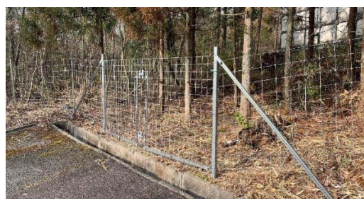
＜設置を完了した金網柵＞
